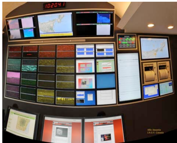
Figura 1. Vista d'insieme della nuova SO.
