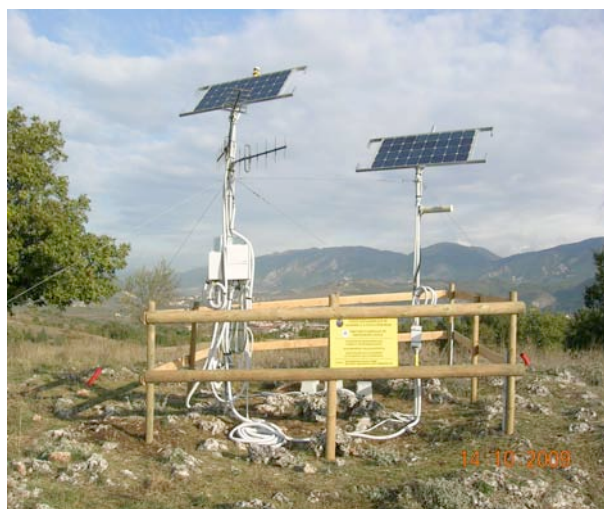
Figura 2. Il sottonodo dopo l'esecuzione dei lavori di consolidamento.
