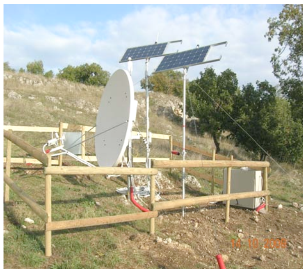
Figura 3. Il centro stella con l'impianto di alimentazione su paliere ed il recinto in abete.
