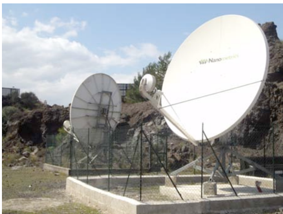
Figura 2. I due Hub satellitari del CUAD di Catania.
