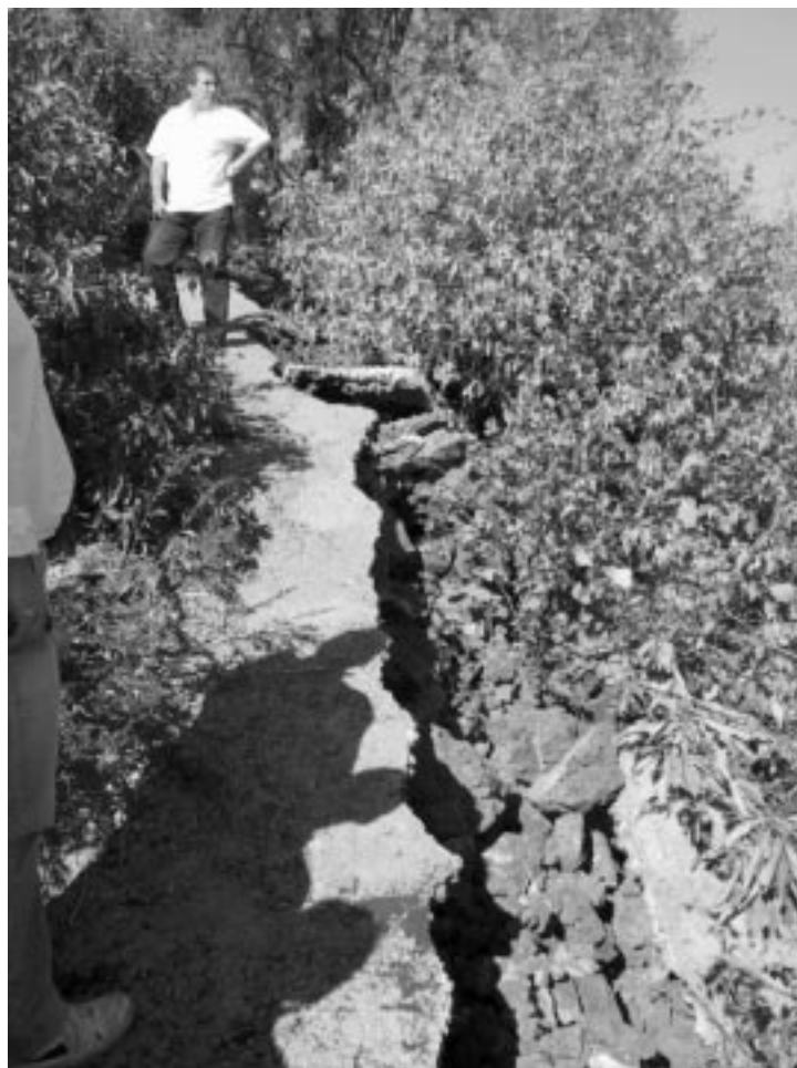
Foto 1.10 Mortari: esempio di dissesto per frana di terrazzamenti in aree coltivate lungo la scarpata della faglia S. Tecla.
