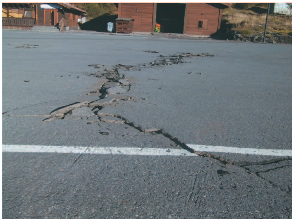
Foto 1.4 Piano Provenzana: dislocazione con componente trascorrente sinistra (foto F. Villa).
