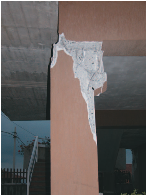
Foto 1.8 Rotture di pilastri in edifici multipiano in c.a. in località Bongiardo (a sinistra) e Felicetto (Linera, a destra).
