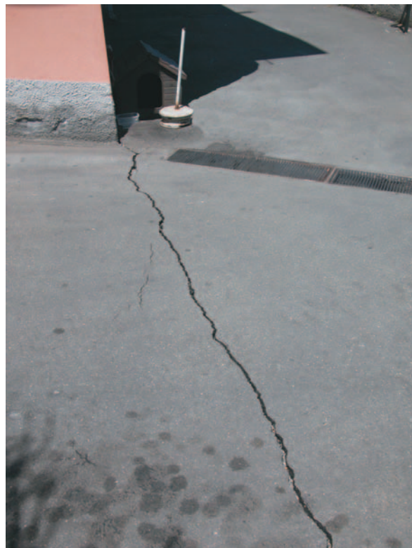
Foto 1.18 Frattura cosismica comparsa lungo la scarpata di faglia ad est della strada provinciale SP185.
