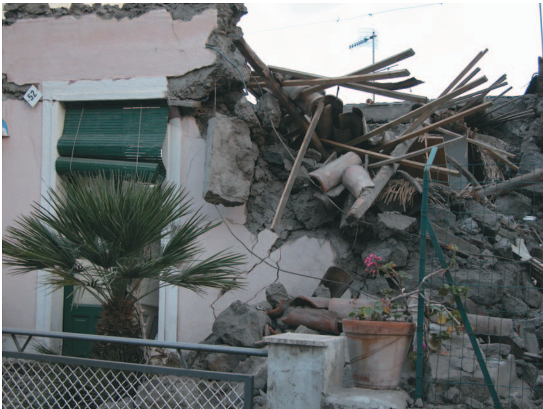
Foto 1.6 Località Scura (Guardia): crollo totale di un edificio in muratura.
