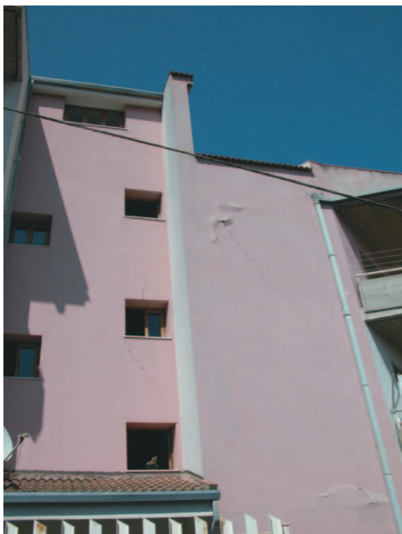
Foto 1.17 Aci S. Lucia (Aci Catena nord): Lesioni alle murature di un edificio in c.a. (cl. D) di recente costruzione, costruito sulla scarpata di faglia. Particolare del danno ad una finestra (a destra).
