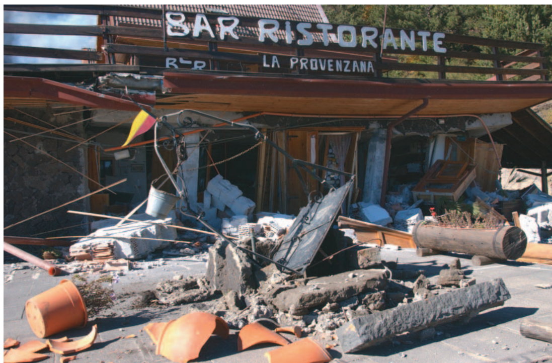
Foto 1.2 Piano Provenzana: crollo parziale di un edificio in struttura intelaiata (foto F. Villa).
