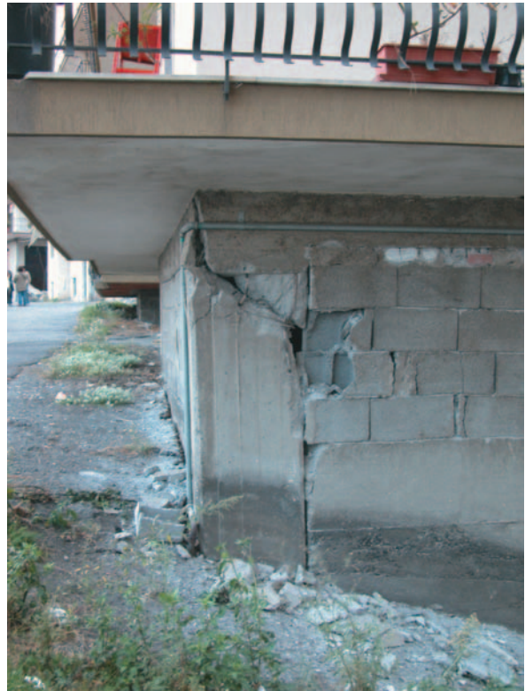
Foto 1.8 Rotture di pilastri in edifici multipiano in c.a. in località Bongiardo (a sinistra) e Felicetto (Linera, a destra).
