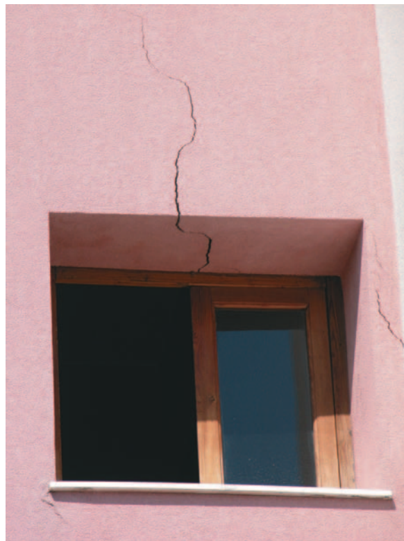
Foto 1.17 Aci S. Lucia (Aci Catena nord): Lesioni alle murature di un edificio in c.a. (cl. D) di recente costruzione, costruito sulla scarpata di faglia. Particolare del danno ad una finestra (a destra).
