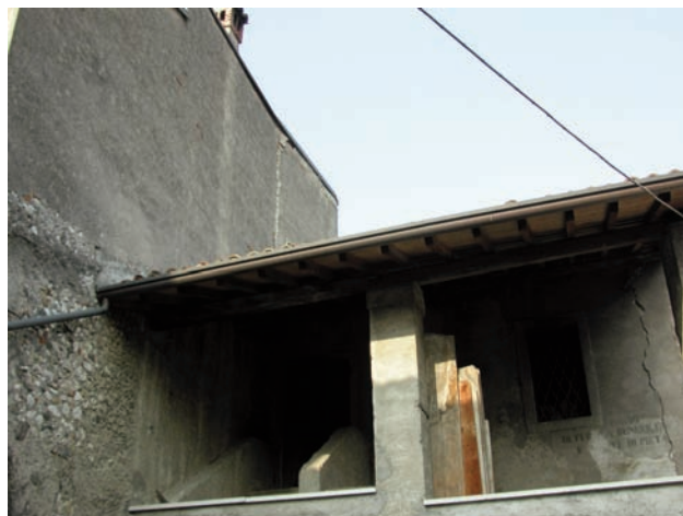
Foto 7-8 Distacco di intonaci nella scuola di Sabbio Chiese e lesioni a un edificio di Gazzane. Photos 7-8 Fall of plaster in the school of Sabbio Chiese and cracks in a poor masonry building at Gazzane.
