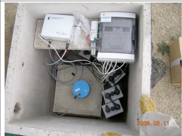
Nodo di Monte Nerone – Apparati radio di dorsale che permettono il collegamento tra la rete HiperLAN AVT e quella SDH Marche-way
