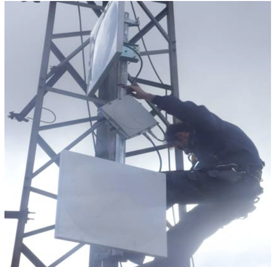
Nodo di Monte Urbino – Apparato radio di dorsale e antenne
