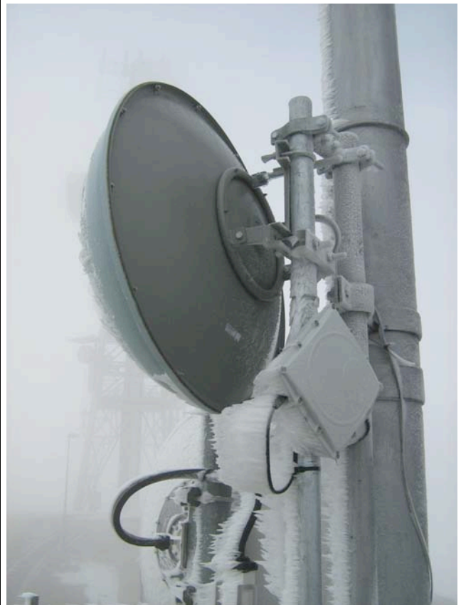
Nodo di Monte Nerone – Apparati radio di dorsale che permettono il collegamento tra la rete HiperLAN AVT e quella SDH Marche-way
