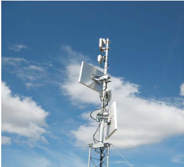
Nodo di Poggio Castellaccio – Apparati radio di dorsale e link
