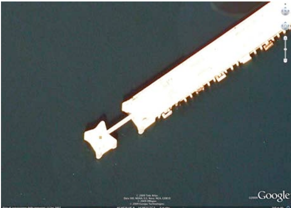
Figura 1. Vista satellitare della punta del pontile.
