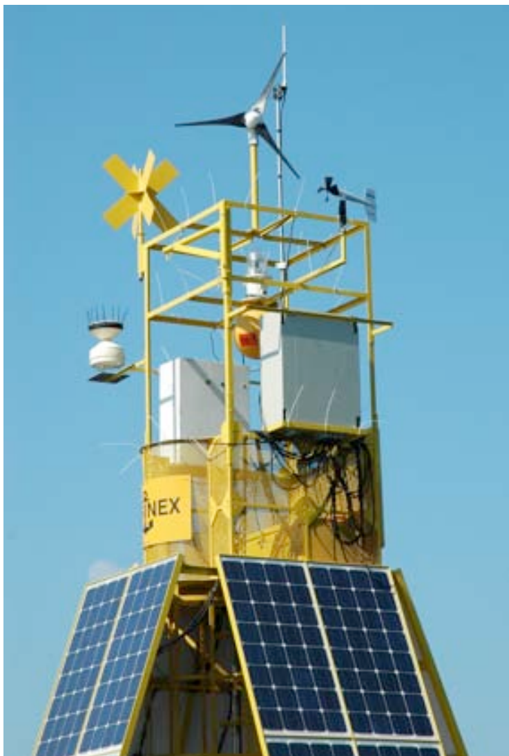
Figura 5. Sommità della struttura fuori acqua della stazione CFSB.
