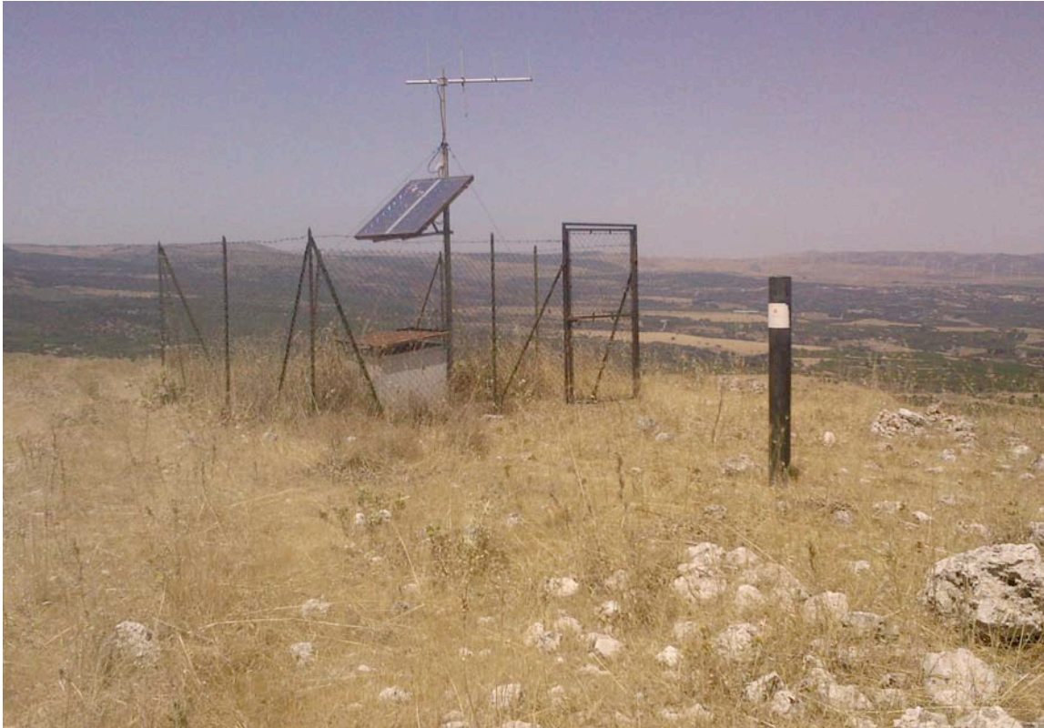
Figura 2. Stazione clinometrica SRC3. Nella foto sono visibili i pannelli solari, l'antenna direzionale verso Catania e sulla destra il pilastrino per misure GPS discrete.
