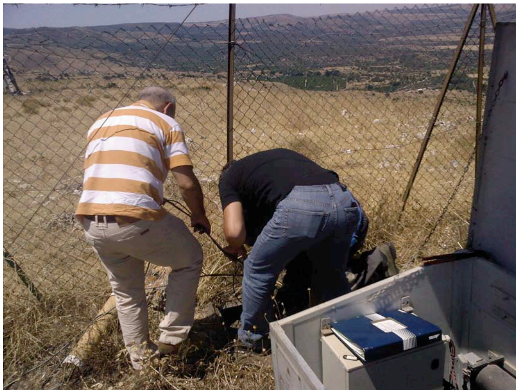
Figura 3. Fase di estrazione del vecchio clinometro.
