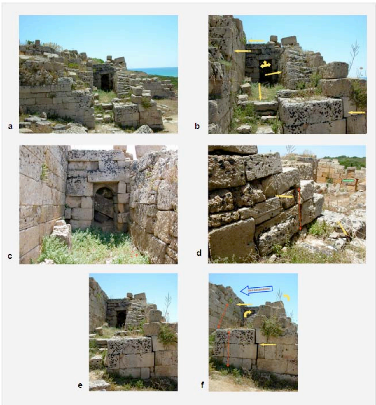
Figura 12 (a-f). Scala, particolare: panoramica della porzione architettonica residua della scala; le frecce gialle indicano i punti di movimento e dislocazione dei conci dalla loro originaria posizione architettonica; le linee in tratteggio rosse indicano fratture longitudinali che hanno coinvolto anche il corpo centrale dei conci.
