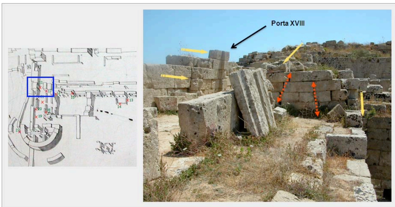
Figura 14. Punti di misura 17, 22: le frecce gialle indicano lo spostamento dei piedritti della Porta XVIII da cui in origine partiva della volta; le linee rosse in tratteggio indicano profonde fratture che attraversano i conci.
