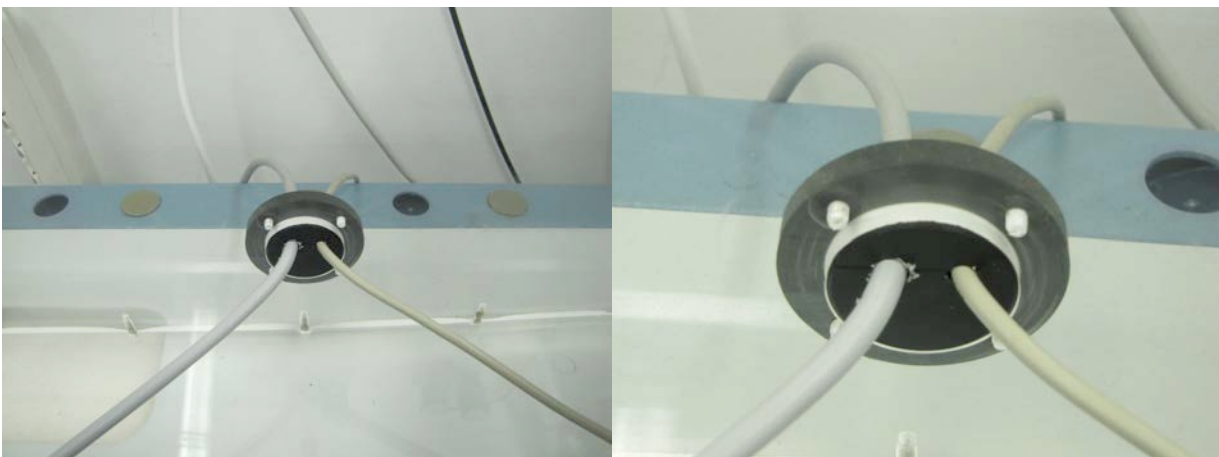
Figura 3b. Realizzazione dei passacavi.
