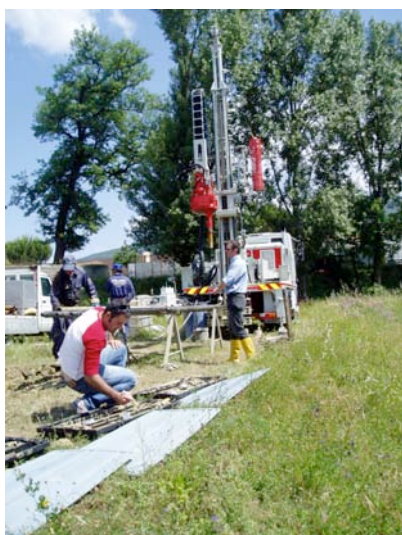
Figura 2.2 Due fasi della realizzazione del sondaggio. La foto di destra mostra il momento in cui il tubo d'acciaio contenente il sistema di bloccaggio viene inserito all'interno del foro durante la fase di realizzazione del rivestimento interno.
