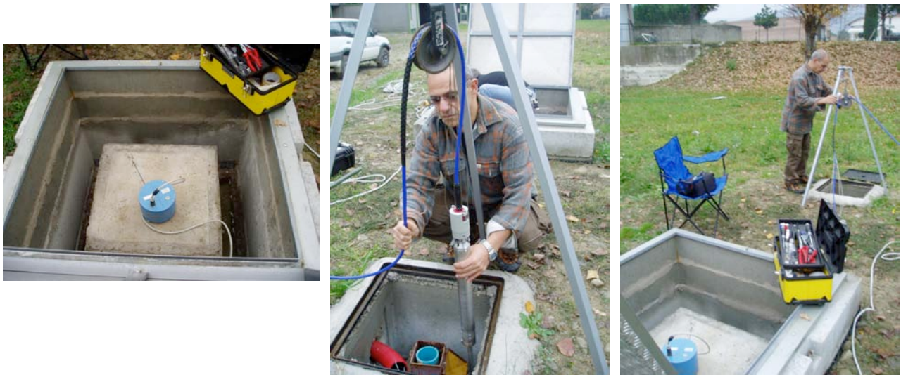
Figura 2.4 Fasi di installazione delle due stazioni sismiche in superficie e in pozzo.
