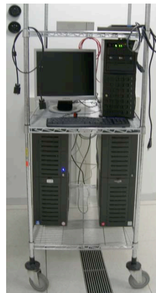
Figura 2 Schema del cluster e foto dei tre computer multi-processore, collegati via rete Gbit, che lo costituiscono.
